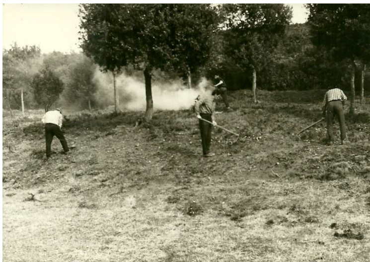
(Foto dei lavori di disboscamento anno 1962)
